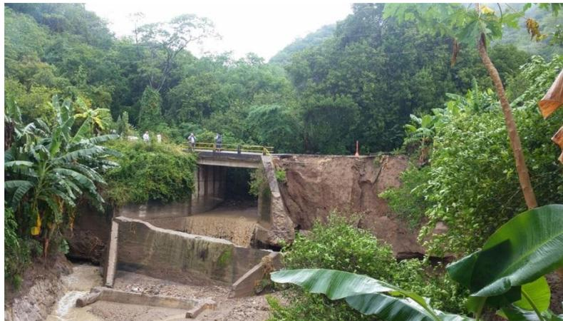
Estado de afectación por creciente de quebrada El Buche, en el PR 14+600 - UF2, afectando la estabilidad de la estructura en concreto, generando un cierre temporal total de la vía entre Girardot y Nariño.
